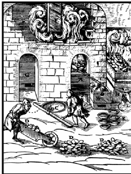
frišovací pec (A, G), vycezoovací pec (H) a pícka pro olovo (B) sloužící k zolovování mědi
