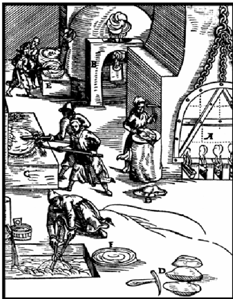
pražící (A) a dodělavací (B) pec na výrobu mědi
